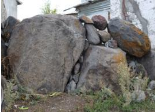
Fotoğraf 7. Baykara Mezarlığının Doğu Yönündeki Mezar Duvarları
